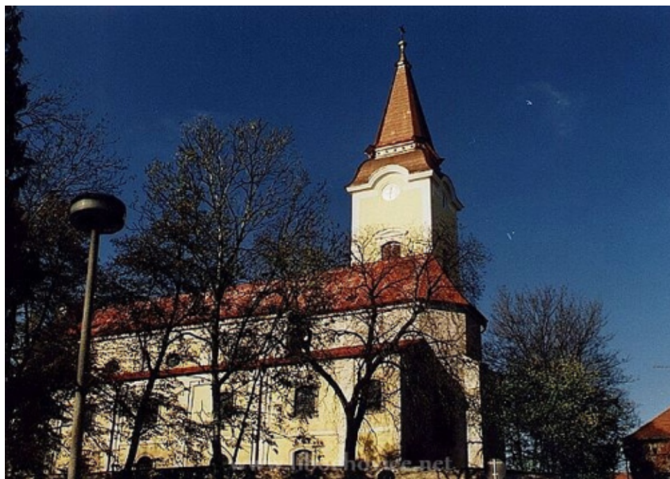
Kostel Všech svatých při opravě a celkový vzhled po opravě - fofo,P.Szeliga 2001
