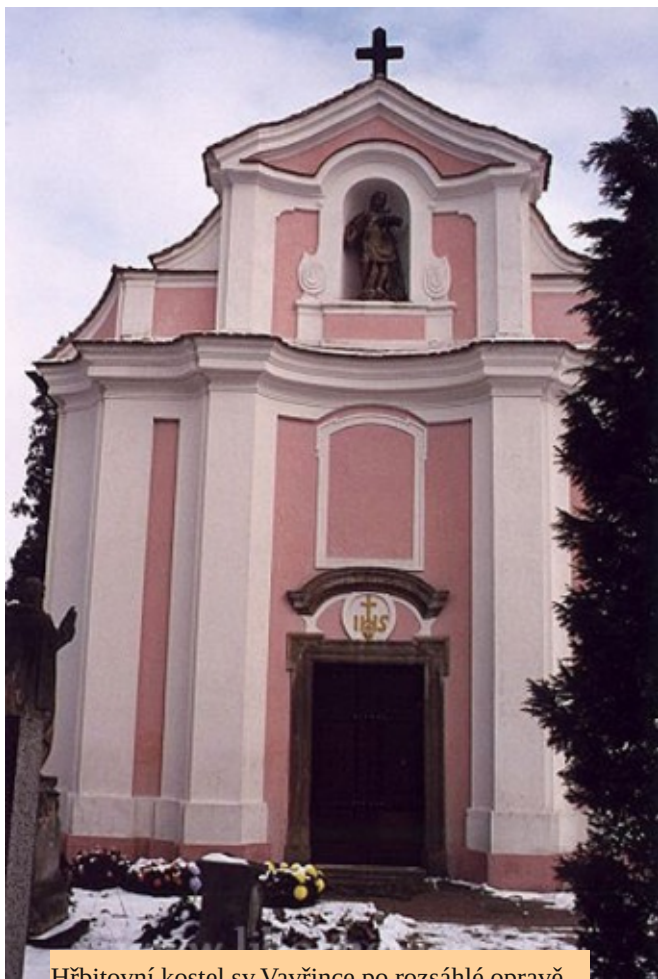
Hřbitovní kostel sv.Vavřince po rozsáhlé opravě
